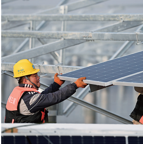
2023年1月5日,建设者在华电海晶光伏项目B标段施工。由中建三局总承包公司承建的天津华电海晶1000兆瓦“盐光互补”光伏发电项目建设稳步推进,项目预计在4月建成完工。新华社发
