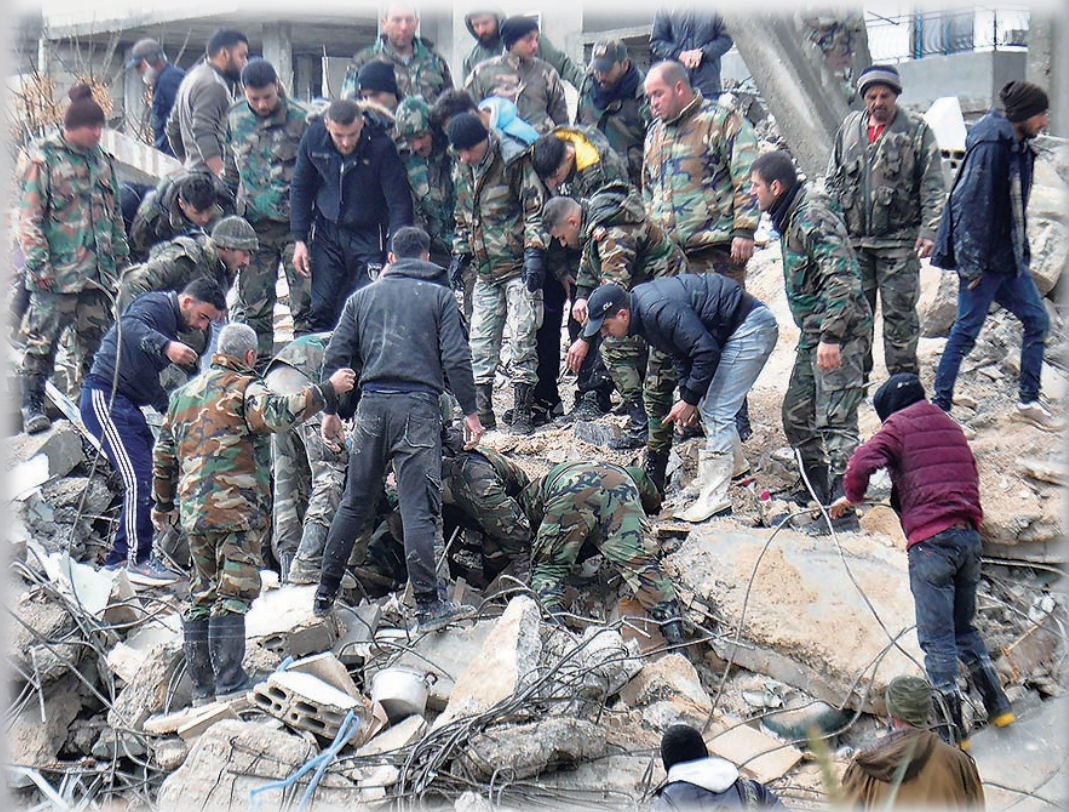
2月6日,在叙利亚拉塔基亚省杰卜莱,人们在一处倒塌的建筑现场进行救援。
