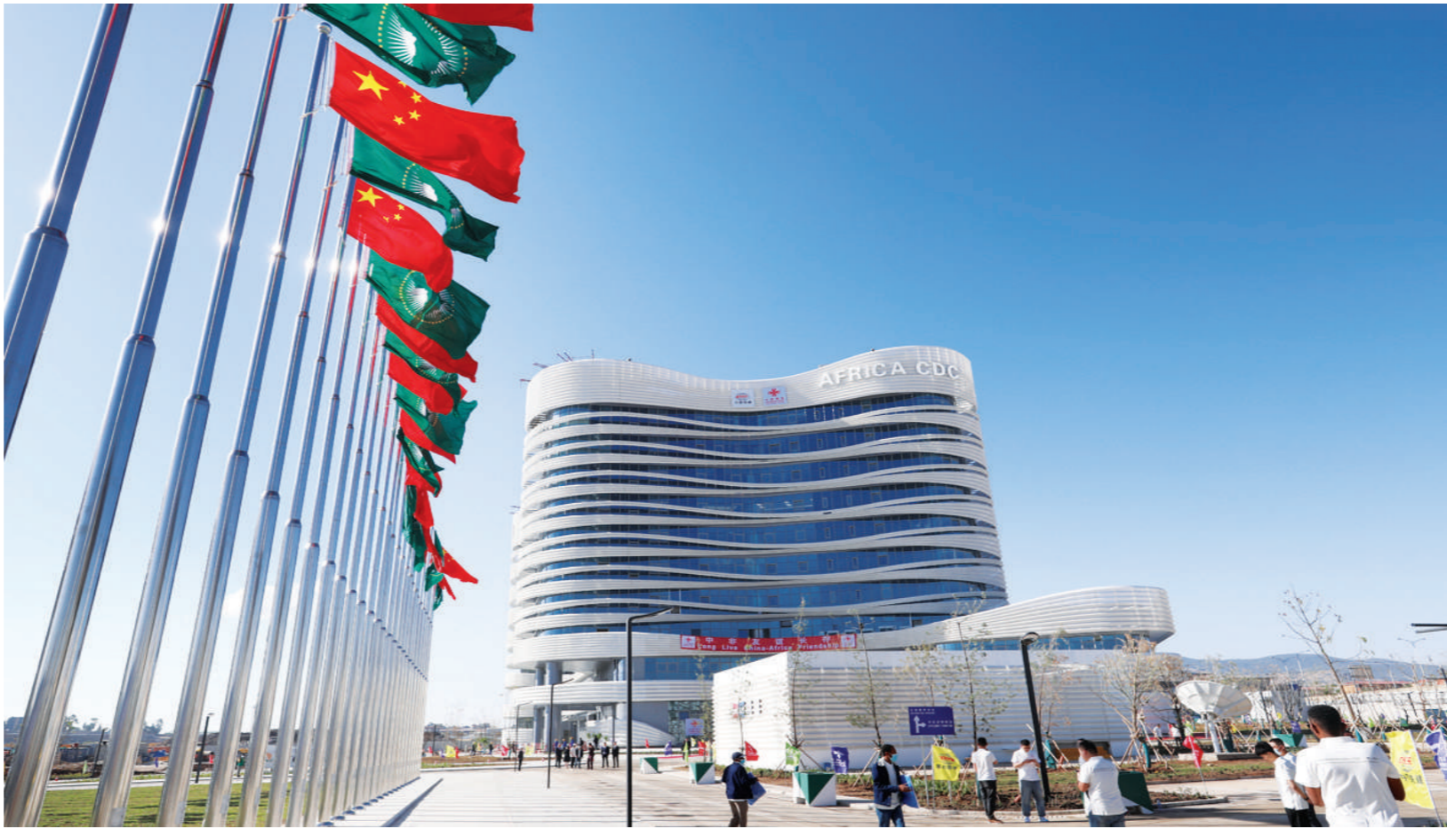
这是2023年1月11日在埃塞俄比亚首都亚的斯亚贝巴拍摄的非洲疾控中心总部大楼。当日,由中国援建的非洲疾控中心总部项目举行竣工仪式。
