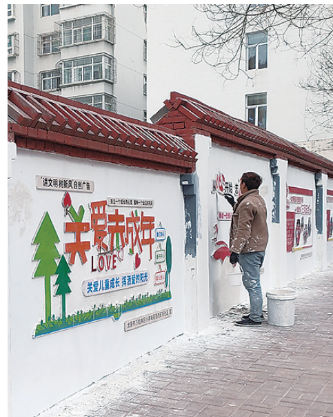
图为施工人员对西矿街北二条的文化墙重新彩绘。
