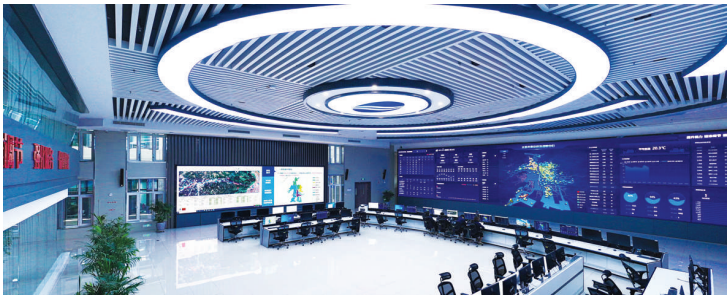
市集中供热调度中心统一调配全市16处大型热源、60余处分布式调峰热源和1937座热力站，是全市热网的“智慧大脑”。
