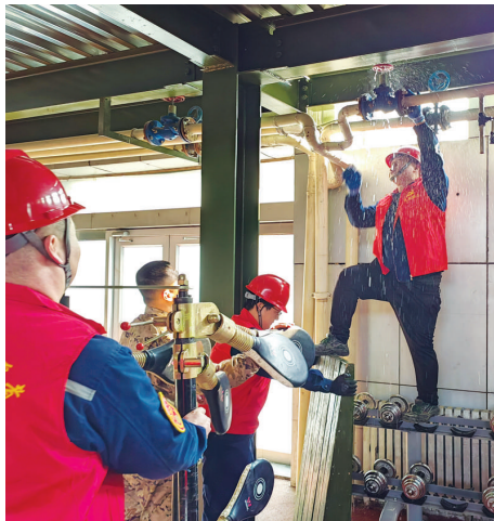
今年年初，武警山西总队训练基地一训练馆供热出现故障，太原热力集团工作人员全面检查管网设施，帮助更换几十组暖气片。
