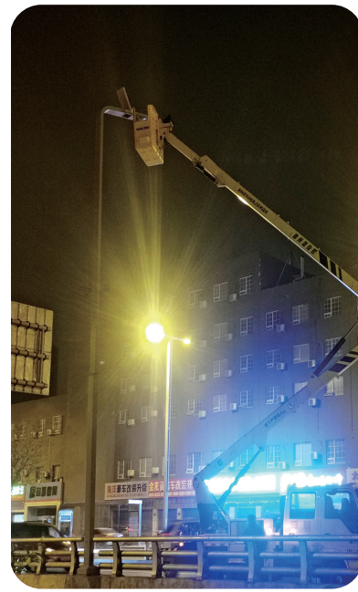
5月7日晚,太原市城市照明管理中心的工作人员对建设南路照明设施进行维护保养,更换老化灯泡,确保市民夜间安全出行。 牛利敏 摄
