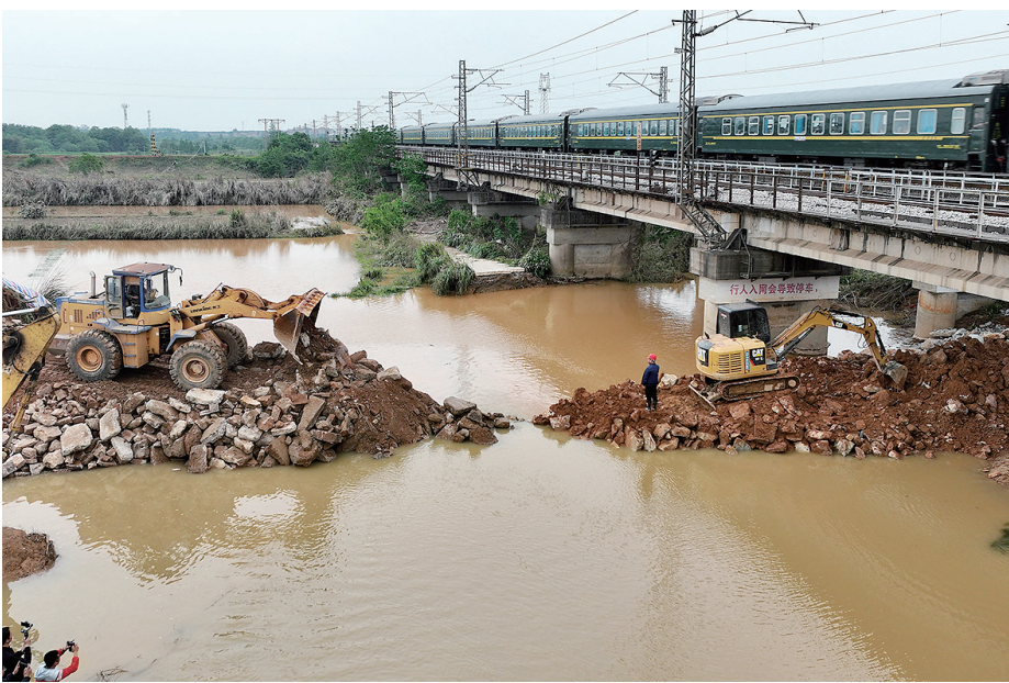
这是在江西省丰城市丽村镇尚山村拍摄的溃口封堵现场(无人机照片,5月7日摄)。新华社发
