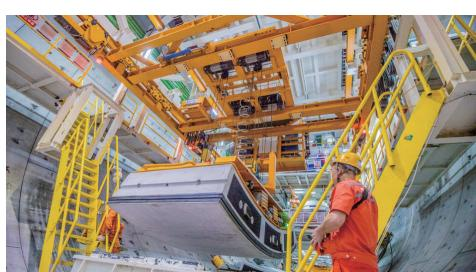
北京城市副中心东六环入地改造工程西线隧道施工现场，“京华号”盾构机正在掘进。新华社发
