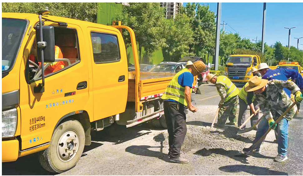
6月10日,在汾东南路路段,太原南郊公路管理段职工对破损道路进行养护作业,以确保道路安全畅通。 阴钰奇 摄
