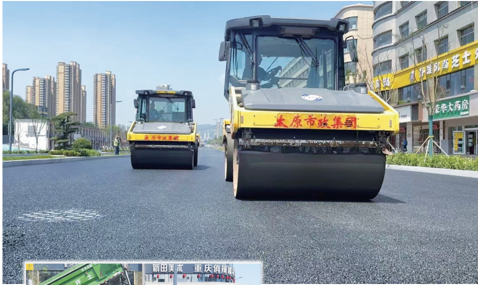
6月16日,市政工人在兴华街开始大面积铺油。此次铺油为路面的最后一层,总面积为10万平方米,整个工作将持续三四天。 司勇 杨斌 摄
