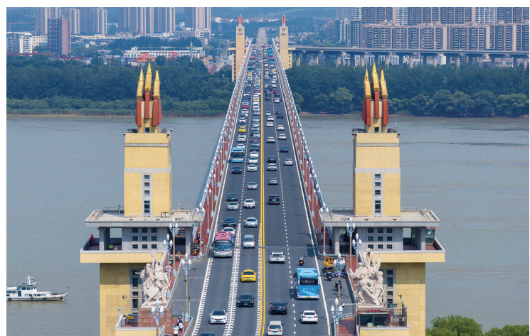
这是南京长江大桥(无人机照片,7月12日摄)。
