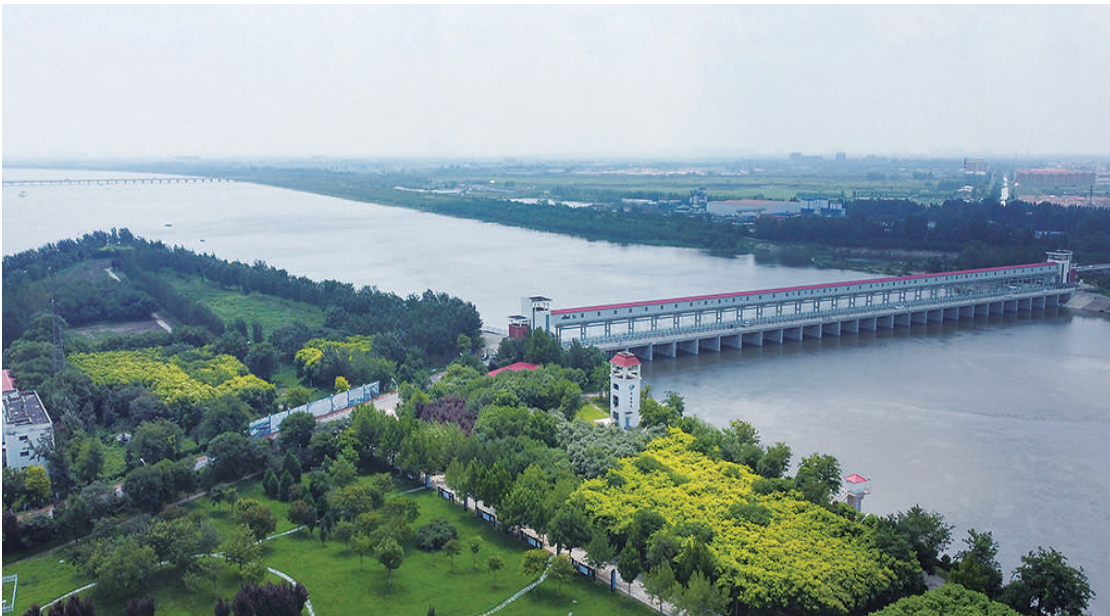
8月2日拍摄的天津市独流减河进洪南闸(无人机照片)。
