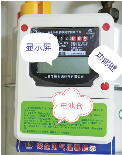
物联网燃气表功能示意图
