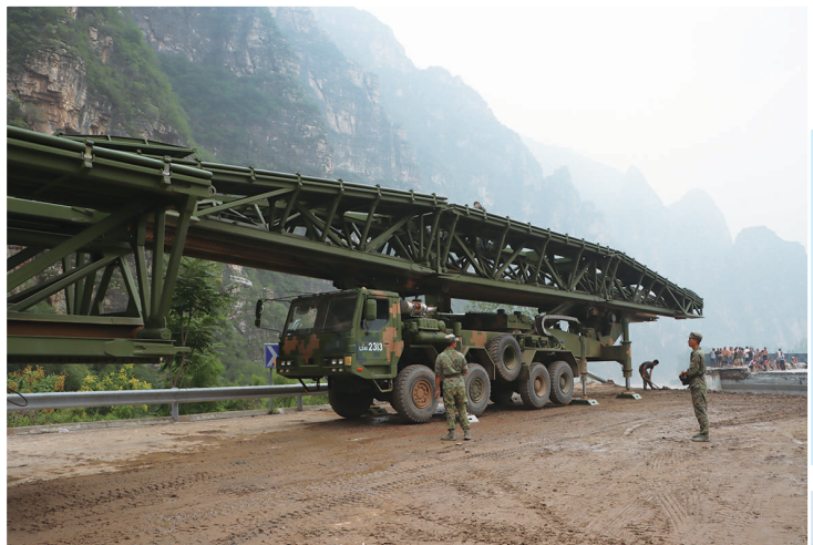
8月3日,中部战区陆军第82集团军某旅官兵在北京市房山区涑宝路四渡桥断桥处架设桥梁。
