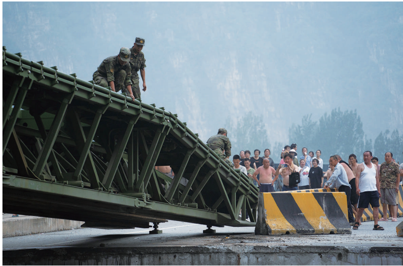
8月3日,中部战区陆军第82集团军某旅在北京市房山区涑宝路四渡桥断桥处架设桥梁,官兵们将导梁架设到对岸。
