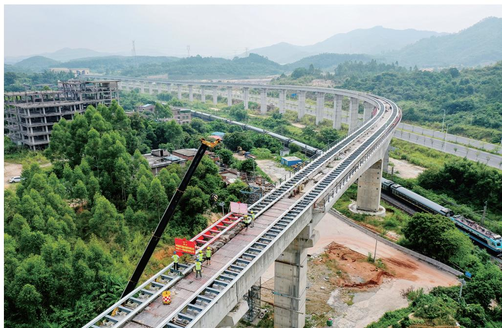
8月10日,广东清远磁浮旅游专线最后一榀轨排被吊装到横跨京广铁路的长隆特大桥上(无人机照片)。
