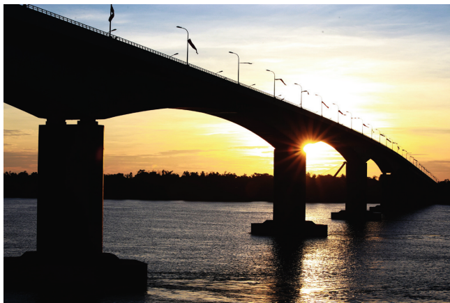
这是2021年11月23日拍摄的由上海建工集团股份有限公司承建的柬埔寨斯登特朗-格罗奇马湄公河大桥。
