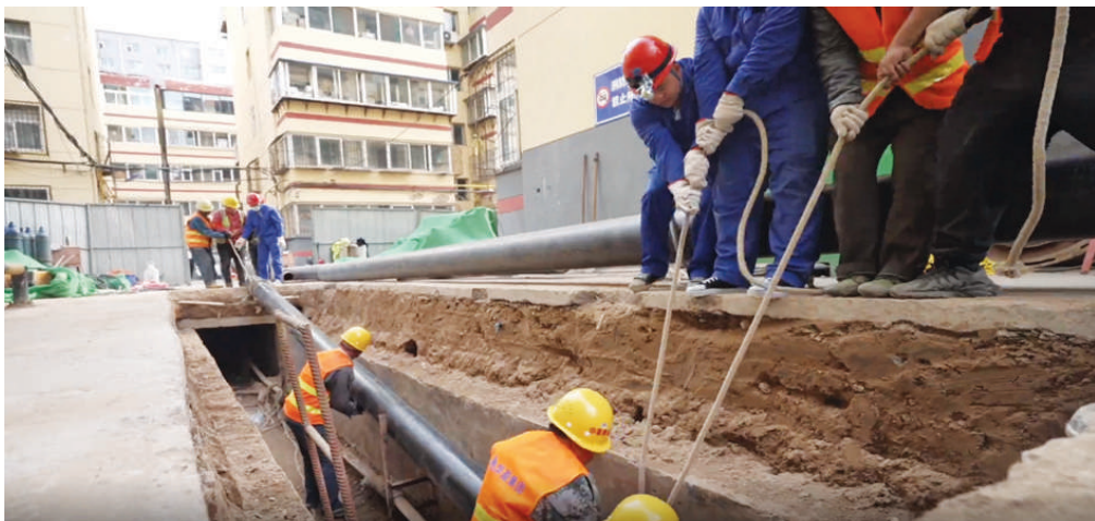
供暖在即,近段时间,太原热力集团对城区范围内部分小区,服役年限超过20年且跑冒滴漏问题严重的用户庭院管网及供热设施进行了更新改造,从源头解决了老旧小区供热管道热损失大、热量输送梗阻等疑难杂症,让老旧小区的用户冬季用热更加安全稳定。截至目前,更换供热管网已超过15公里。 刘亮亮 摄
