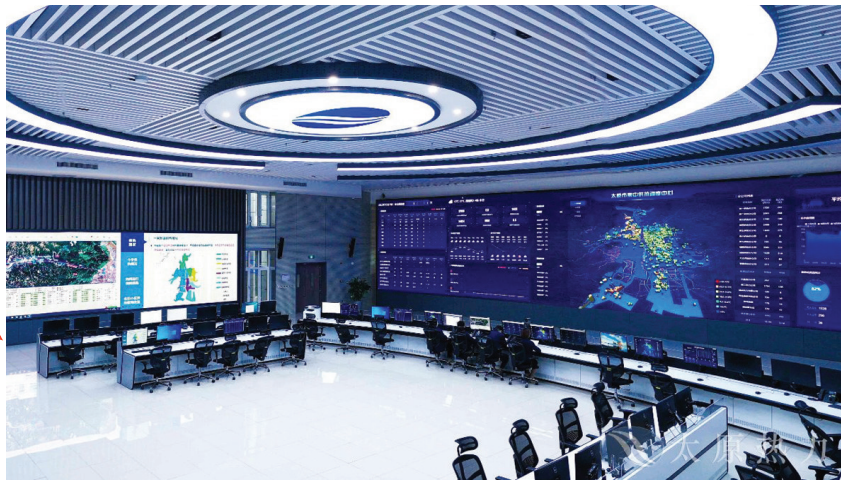
太原市集中供热调度中心是全市供热系统的“智慧大脑”“神经中枢”,负责对全系统的源、网、站、户(即热源厂、管网、热力站、用户)及运行参数进行实时监测、科学调整。
