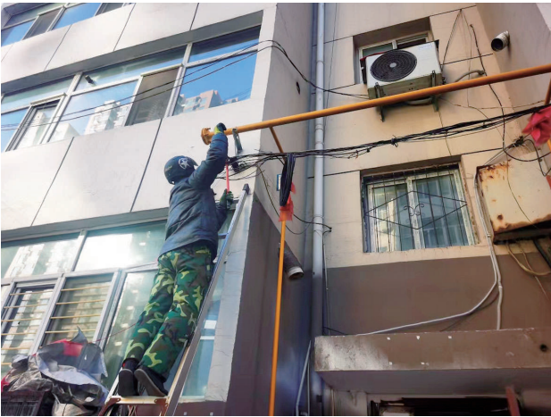
施工人员进行拆除架空线缆。
