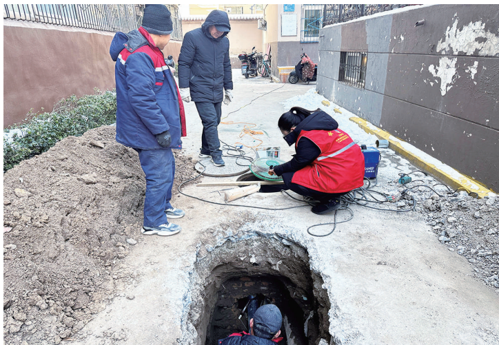
维修工人抢修供热管道。
