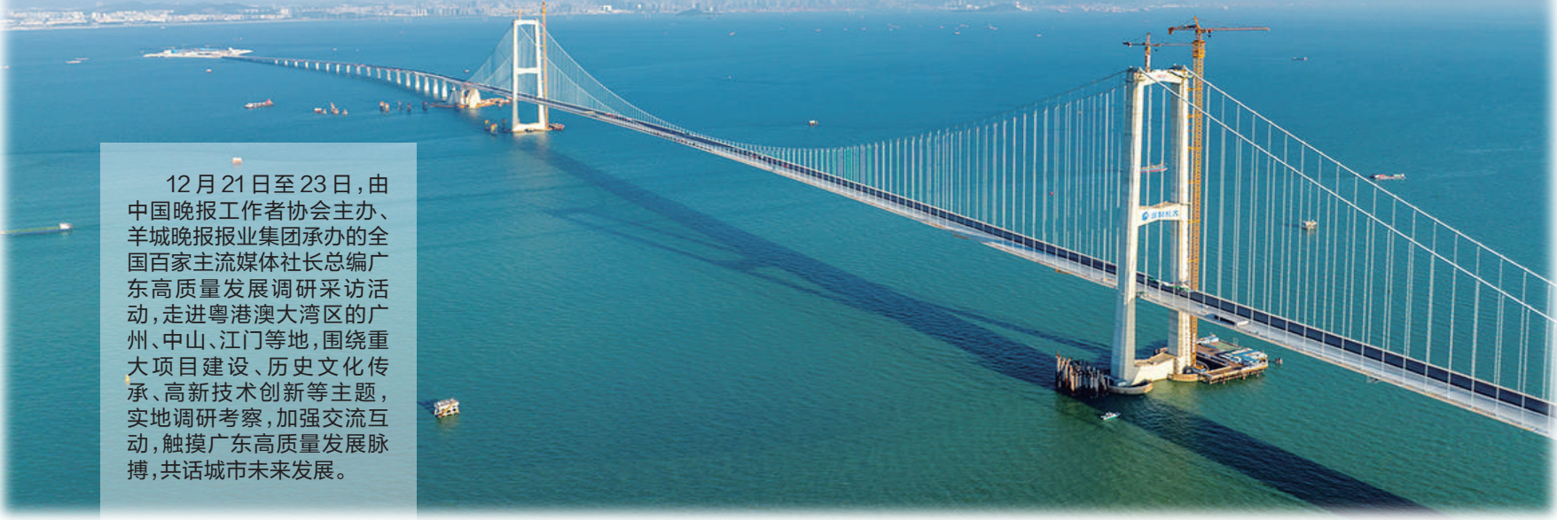
深中通道主跨1666米的伶仃洋大桥,是世界上最大跨径全离岸钢箱梁悬索桥,也是世界上通航净空最高的海中大桥。
