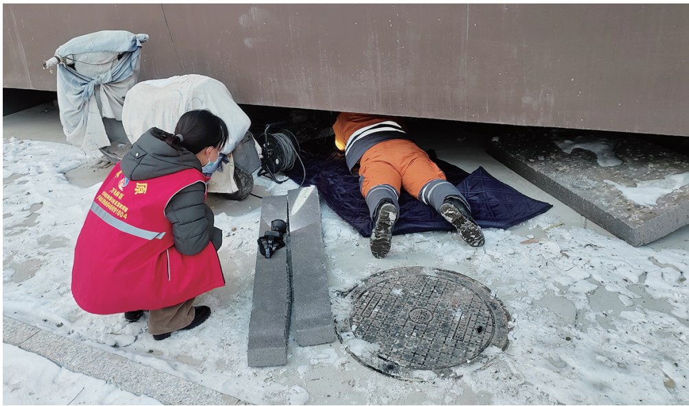
维修人员钻到阳台下方,给水管实施保温处理。
