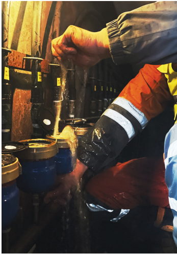
水表冻裂，抢修队员带水作业。
