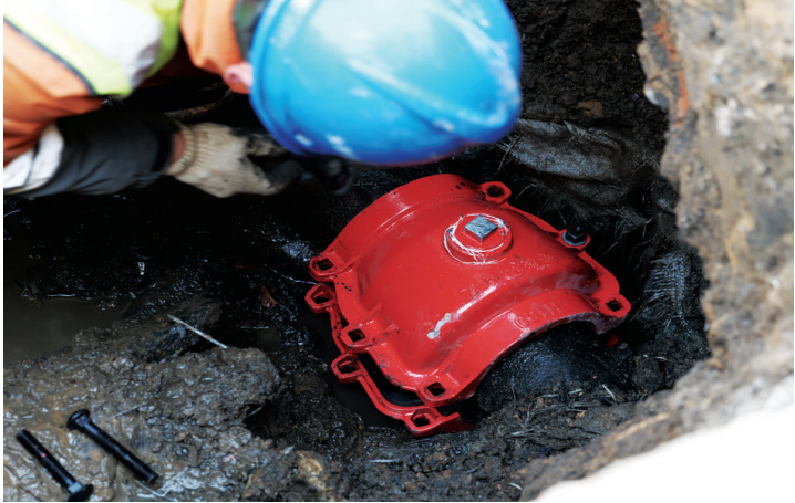
安装哈夫节对管线破裂处进行包箍处理。
