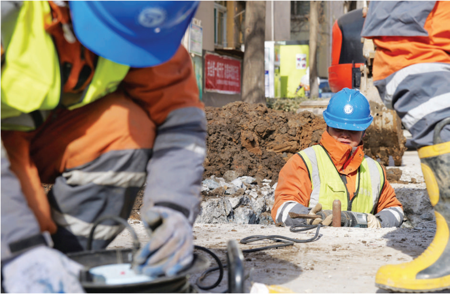
开挖漏水管道上方路面。
