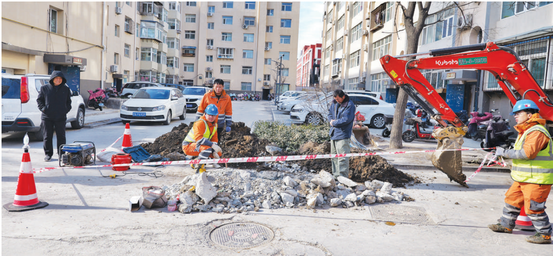
安装哈夫节对管线破裂处进行包箍处理。
