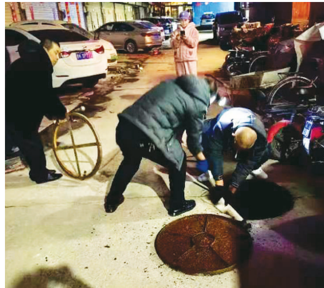
正月初六晚上，迎新街街道南固碾社区为居民清掏管道。
