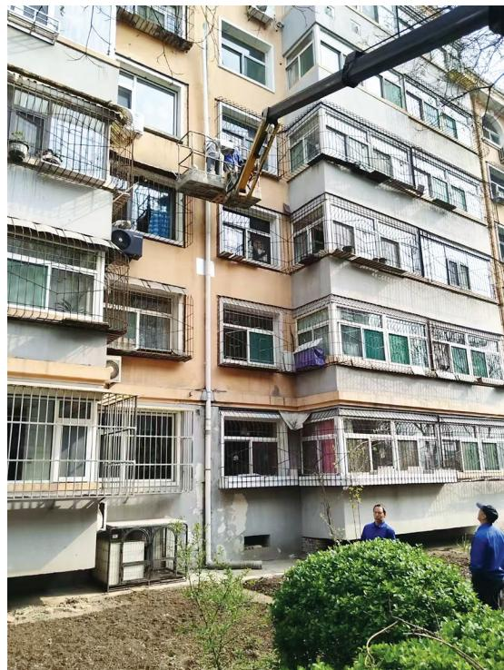
本报讯(记者 李涛 网格通讯员 赵文婷 文/摄)雨季将至,但居民楼的雨水管存在堵塞、破损情况。网格员巡查发现后,及时协调物业,调来高空作业机械,对小区60余栋楼的雨水管进行全面疏通、维修。
