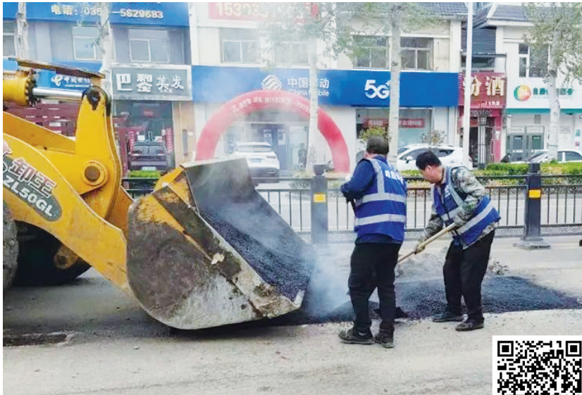
图为施工人员修复破损路面。
