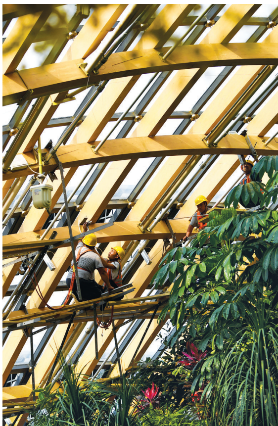
5月12日,太原植物园首次对温室木结构进行维修养护施工。该园展览温室是国内首个采用胶合木结构的大型展览温室。
