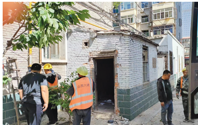
施工人员协助居民拆除违建。
