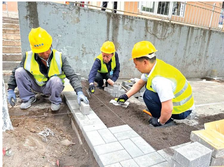
画出需要切割的线条,并按画好的线条,精确地将面砖切割。这些“细活”,是为了确保设施周围的铺砖与整个地面无缝衔接,铺设后整个路面更加平顺一体。
