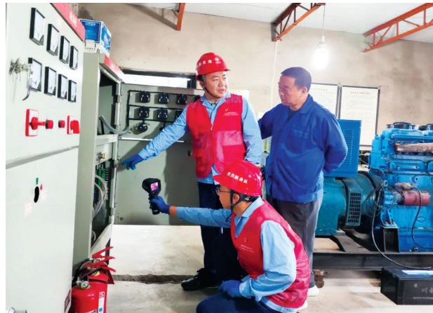
供电运维人员检查线路设备。
