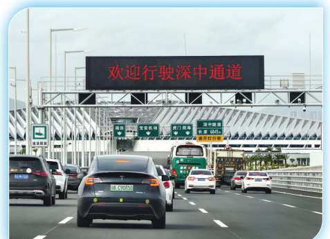
这是开通首日的深中通道西人工岛路段车流(6月30日摄)。
