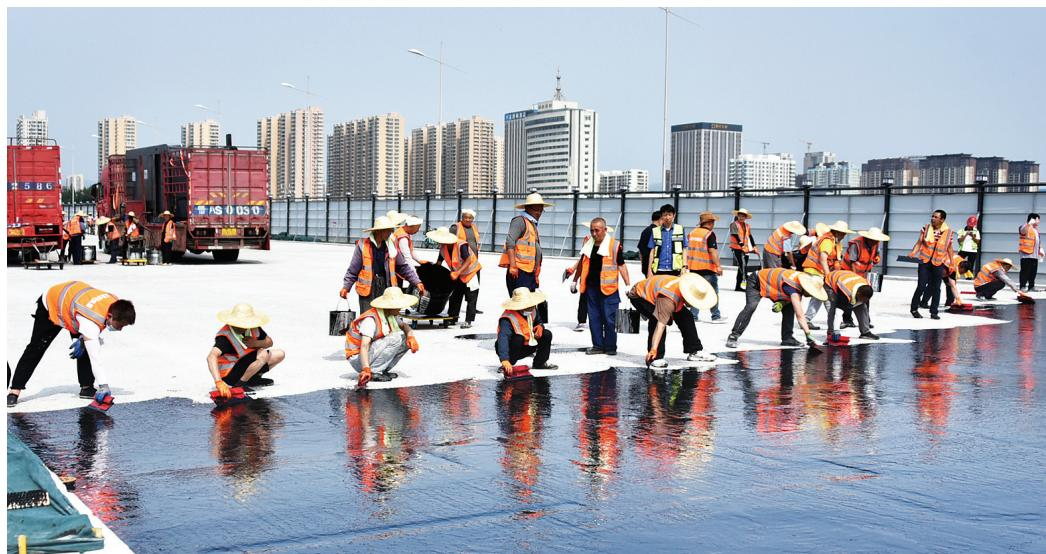
7月8日，迎泽大桥改造加固工程施工现场，工人们顶着烈日为路面涂刷环氧沥青粘结剂。该工程在对桥面钢纤维混凝土精铣刨的基础上，进行环氧沥青粘结剂的涂刷，以有效防止雨水下渗，保护桥梁结构，延长桥梁使用寿命。
