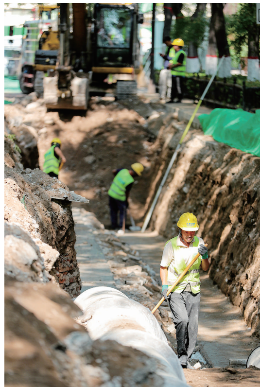
7月10日,太原市政公共设施建设管理中心负责的新民北街雨污分流混接点改造项目现场,工作人员正在铺设管道。该项目改造后将实现雨污分流,进一步提升城市汛期排涝能力。王韵菲 狄佳玮 摄
