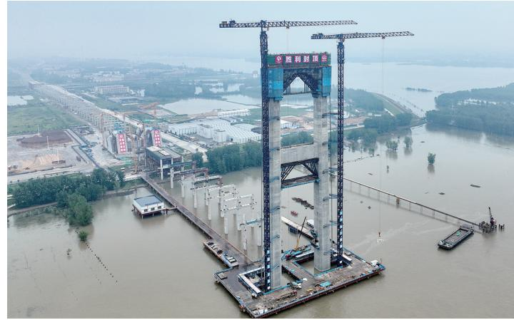
7月14日，燕矶长江大桥主塔全部封顶。大桥采用双塔单跨设计并一跨过江，主跨1860米。作为鄂州国际物流核心枢纽的综合配套工程，燕矶长江大桥是鄂东空铁、空陆联运立体交通运输体系的重要过江通道，也是推动黄冈、鄂州、黄石三市跨江联动开发，促进三市一体化发展的关键工程。
