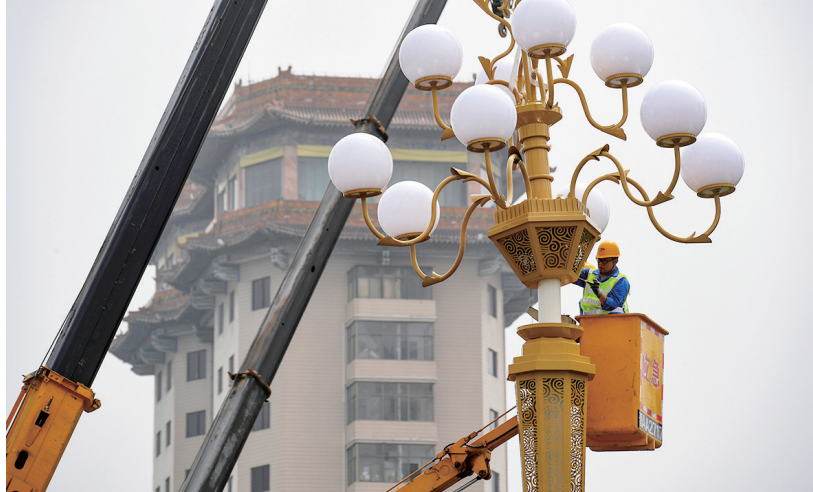
施工人员正在对路灯进行安装调试。牛利敏 杨斌 摄影报道
