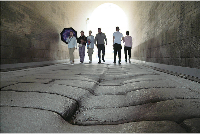
7月14日,游客在嘉峪关关城游览。城门下的地面,在车轮的长期碾压下形成明显的车辙。
