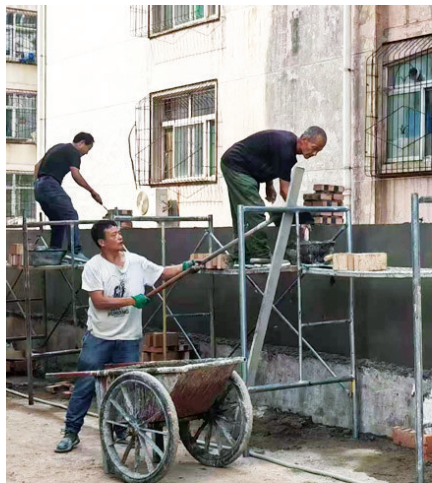
施工人员修复开裂墙体。
