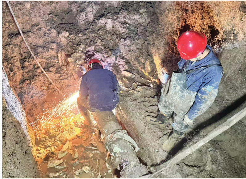
供热初期有跑冒滴漏问题,维修人员正在切割、焊接损坏管道。
