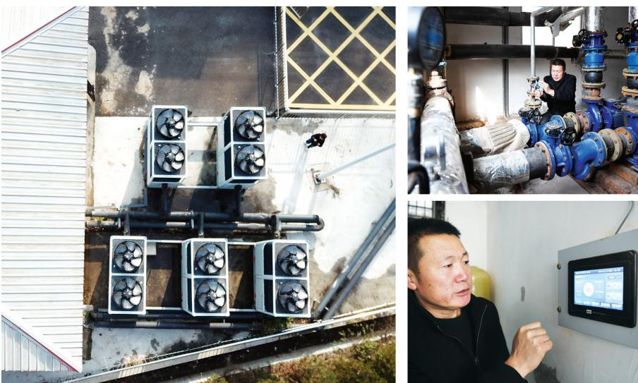
12月1日,在杏花岭区大窑头村大窑头小区,刚刚投入使用的智能空气源热泵设备稳定地为100余户村民供暖。该村党支部书记郭鹏介绍,以前村里用的是传统电锅炉,费电且制热效果不稳定。今年更换了空气源热泵设备,通过近一个月的使用观察,电费较往年下降了50%以上,而且智能化程度高,不仅通过手机就能设定温度,而且设备能根据天气情况自动设定温度,给村民带来舒适与便捷。
