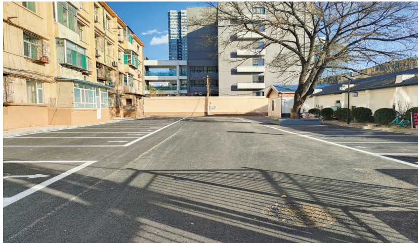
小区拆除违建,增设了停车位。
