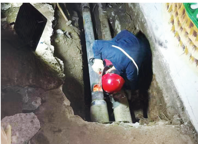
抢修人员在汾河隧道管理所小区更换损坏管道。
