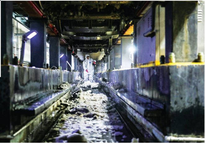
高压热水枪打冰除雪
