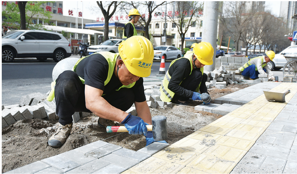
4月16日,工作人员正在对师范街破损便道进行修复。在市政设施大排查大整治大提升专项行动中,市市政建管中心各道排保障所的工作人员及时对管辖区内的便道砖松动、下沉、破损等进行维修整治。 牛利敏 杨斌 摄影报道
