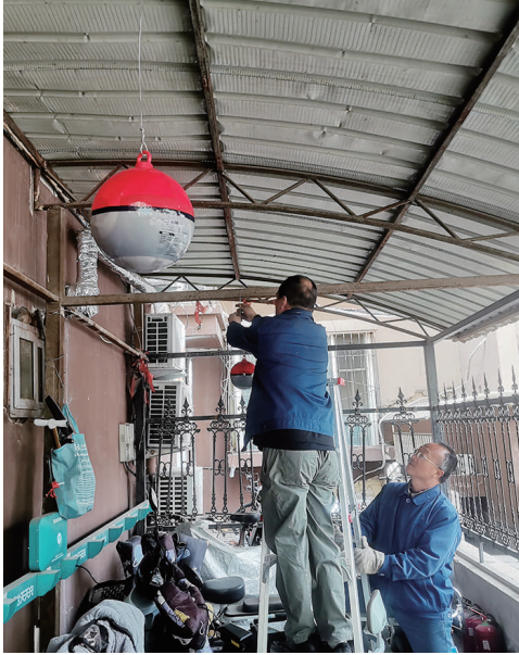
小区车棚安装自动灭火球
