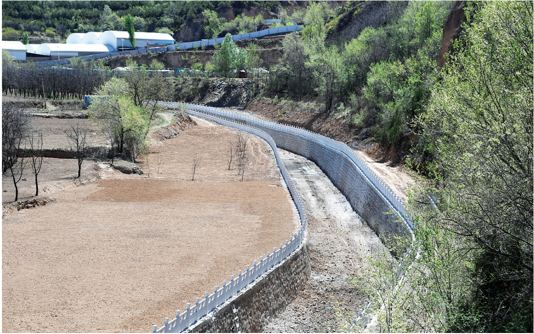
5月13日,杏花岭区小返河综合治理工程主体工程已完工,即将进行绿化施工。该项目全长6.24公里,项目实施后,不仅可消除两岸堤防的安全隐患、提高河道防洪标准,而且对改善生态环境具有积极作用。 牛利敏 郝晨光 摄影报道
