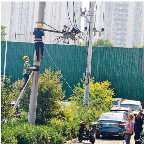
工作人员正在拆除倾斜的废弃电线杆
