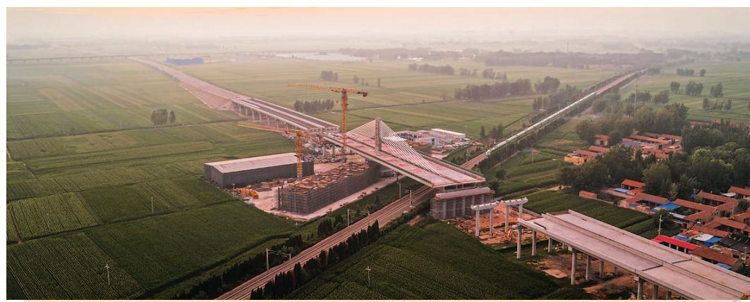
一辆列车驶向转体完成的斜拉桥（8月6日摄，无人机照片）。
