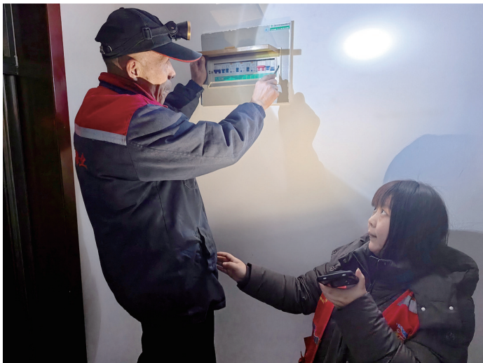
网格员孟雅洁与电工师傅春节期间上门维修电路
