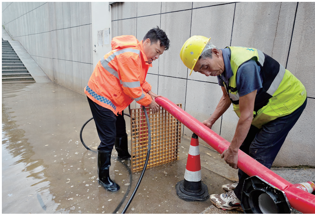
8月12日,我市迎来降水,市政建管中心快速响应,全力投入城市排水工作。图为桥梁管理所在龙城大街下穿通道抽水、排水。杨斌 摄
